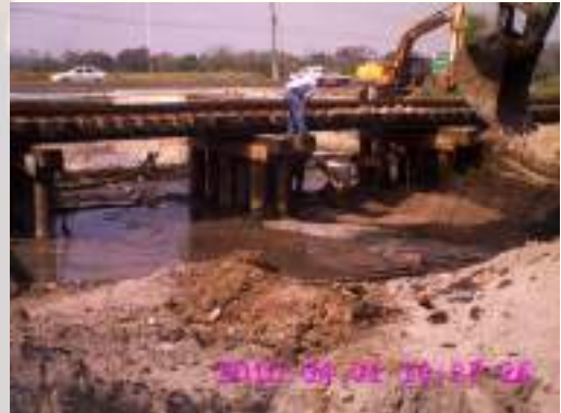
Sistema Lagunar Las Bajadas
