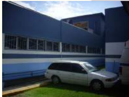
Reparación Hospital del ISSSTE
